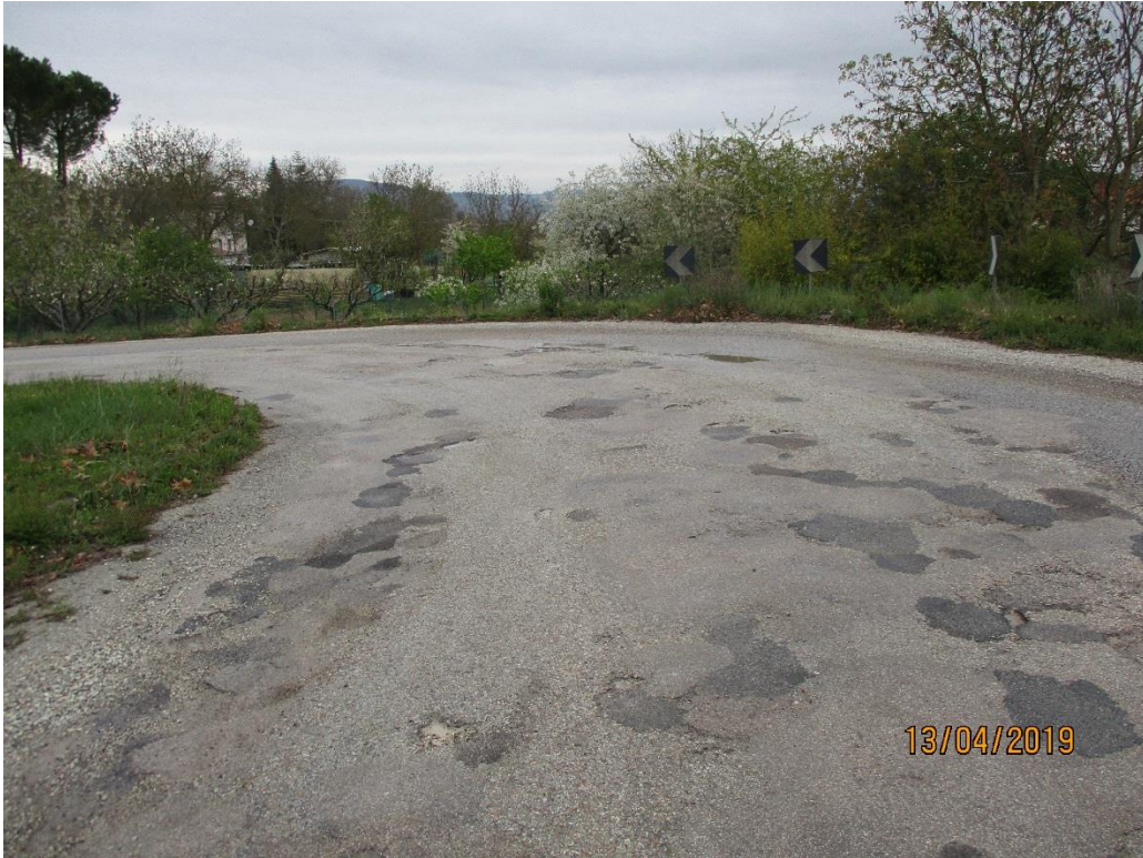
Intervento 2: Strada Zona Industriale Pantana
