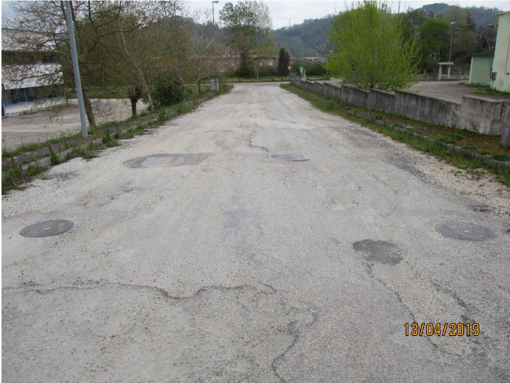
Intervento 2: Strada Zona Industriale Pantana – Traversa 1
