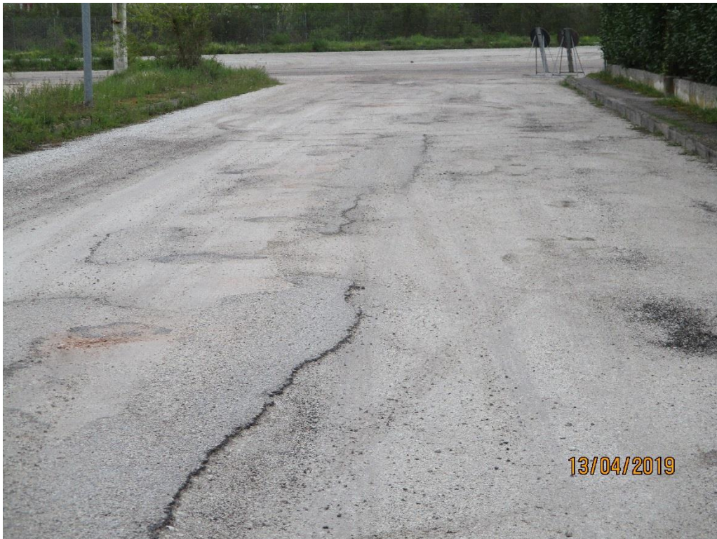
Intervento 2: Strada Zona Industriale Pantana – Traversa 2
