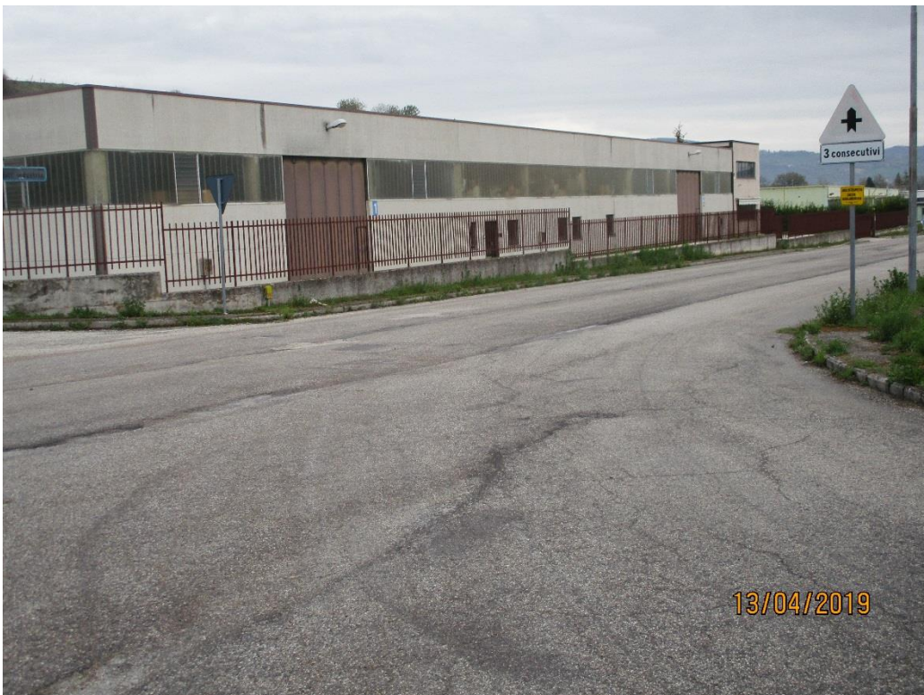
Intervento 2: Strada Zona Industriale Pantana - Incrocio
