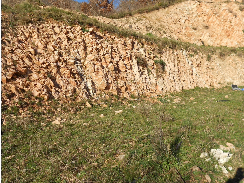
Particolare dello stato di alterazione dell'ammasso roccioso
