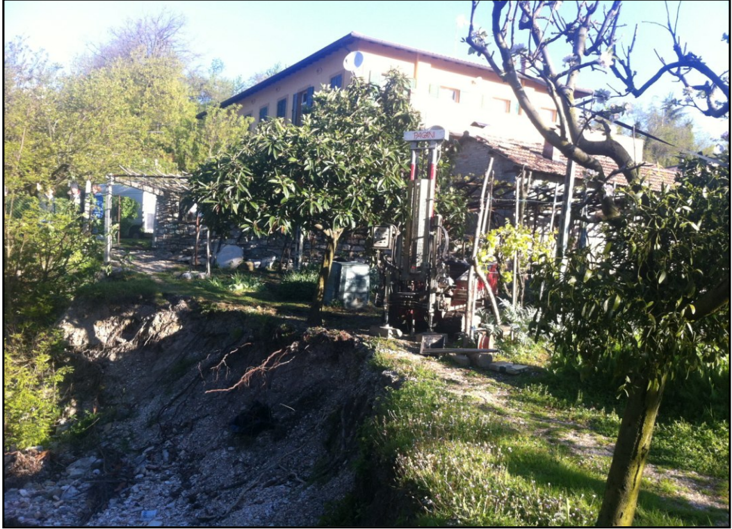
Foto 1: Ubicazione prova penetrometrica dinamica DPSH 1
