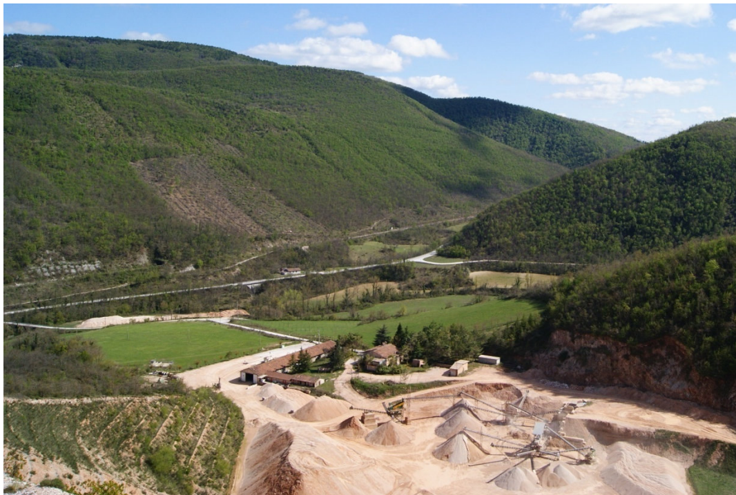
Figura 8 – Vista dell'area dei fabbricati e dell'impianto di vagliatura, ripresa da un gradone della cava. Sulla sinistra una porzione di cava recuperata.
