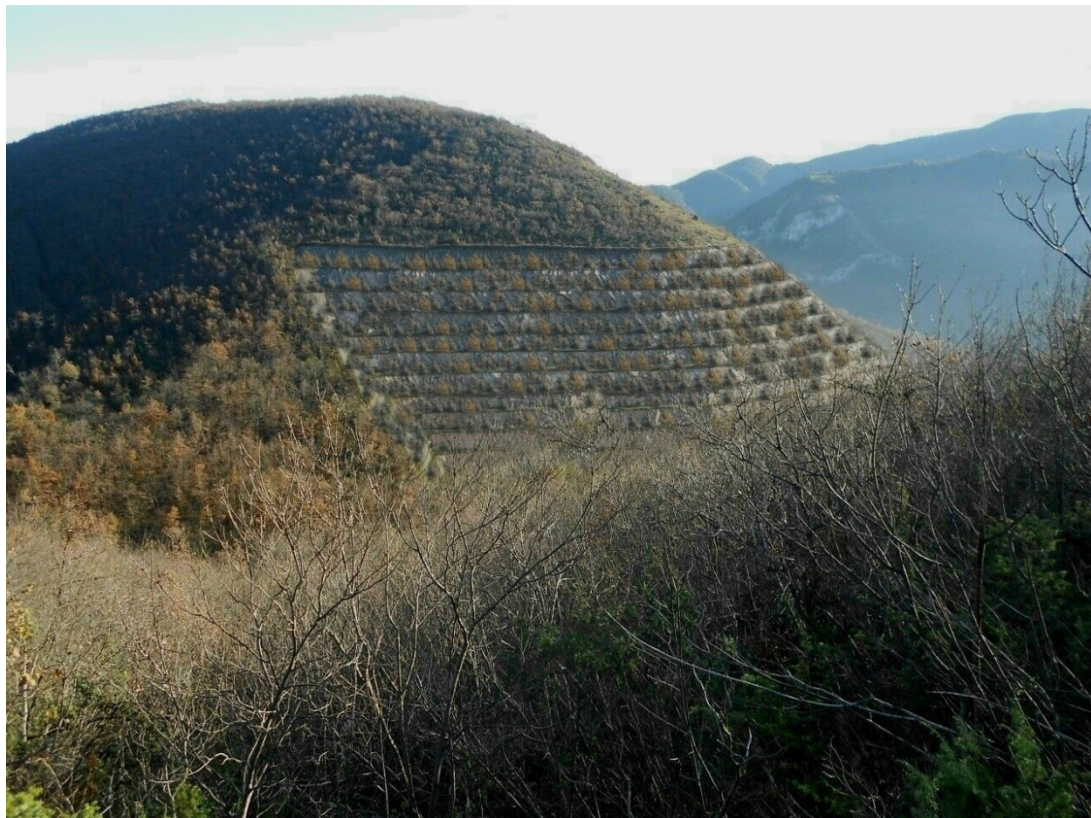
Figura 10 – Situazione ad ampliamento avvenuto, a recupero affermato.
