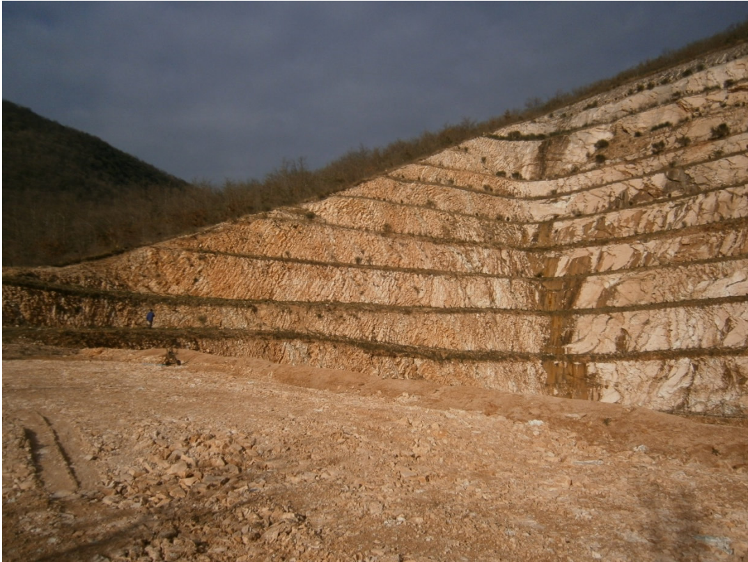
Figura 5 – Immagine del fronte oggetto d’arretramento. Il punto di ripresa è l’attuale piazzale in fase di recupero.
